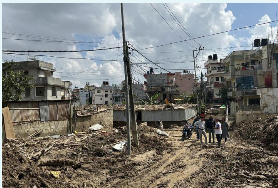
图48：2024年9月尼泊尔严重洪灾后的破坏情况
