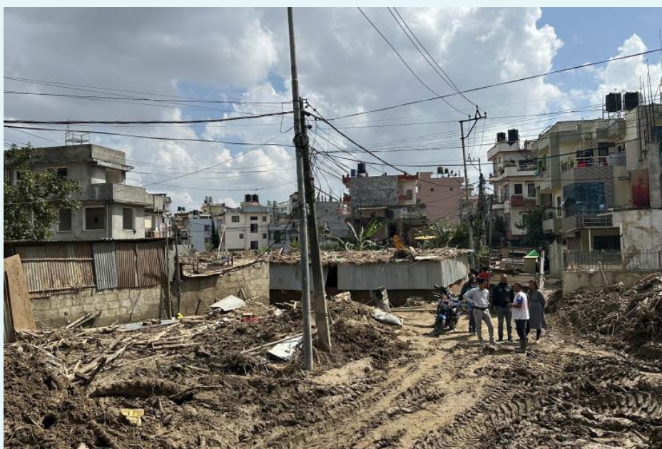
Figura 48. Daños tras las graves inundaciones en Nepal en septiembre de 2024
