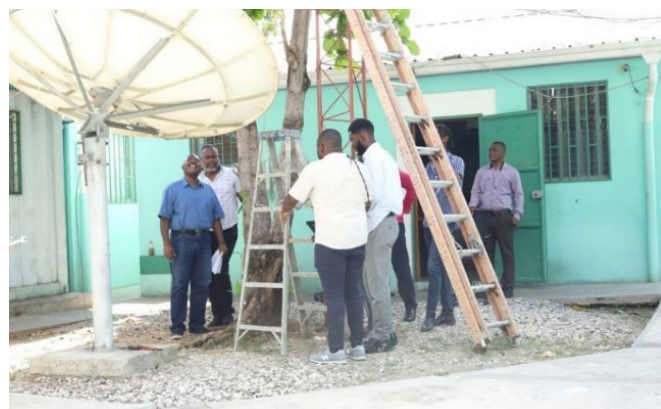
Figura 23. Mejor acceso a los datos: instalación del sistema GEONETCast en Haití
